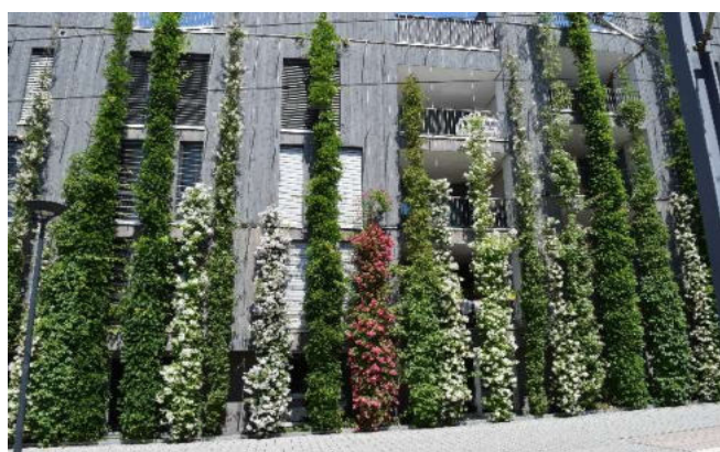
Eine bodengebundene Fassadenbegrünung kann im Frühjahr prachtvoll blühen © BuGG, G. Mann
